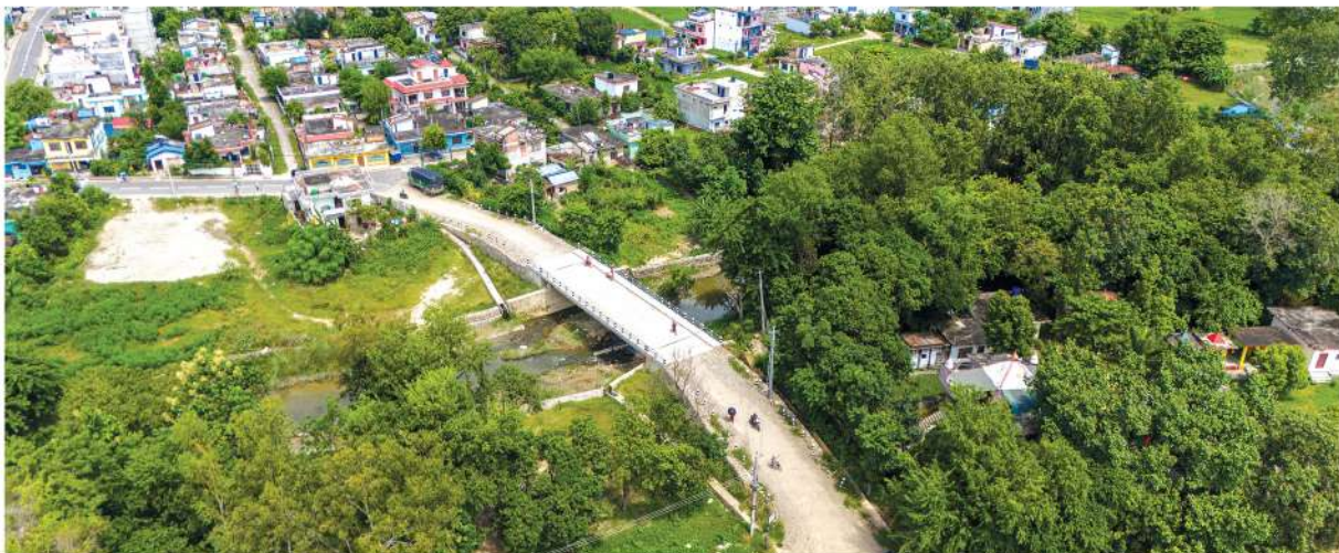
धनगढी उपमहानगरपालिका अन्तर्गत वडा नं. १ र वडा नं. ८ जोड्ने पुल
